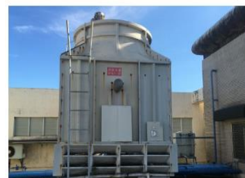
冷卻水塔散熱材更換
