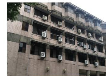
汰換為變頻分離式冷氣機
